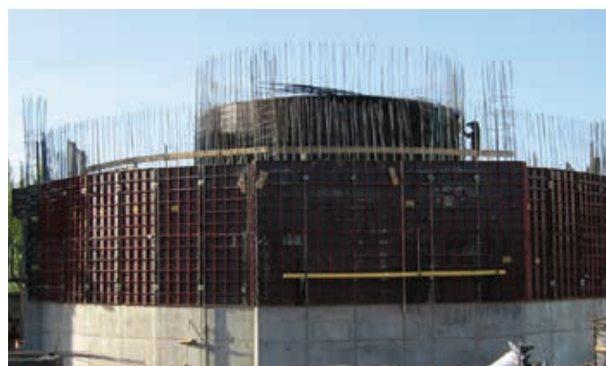
Наружные и внутренние вставки для формирования криволинейных поверхностей
