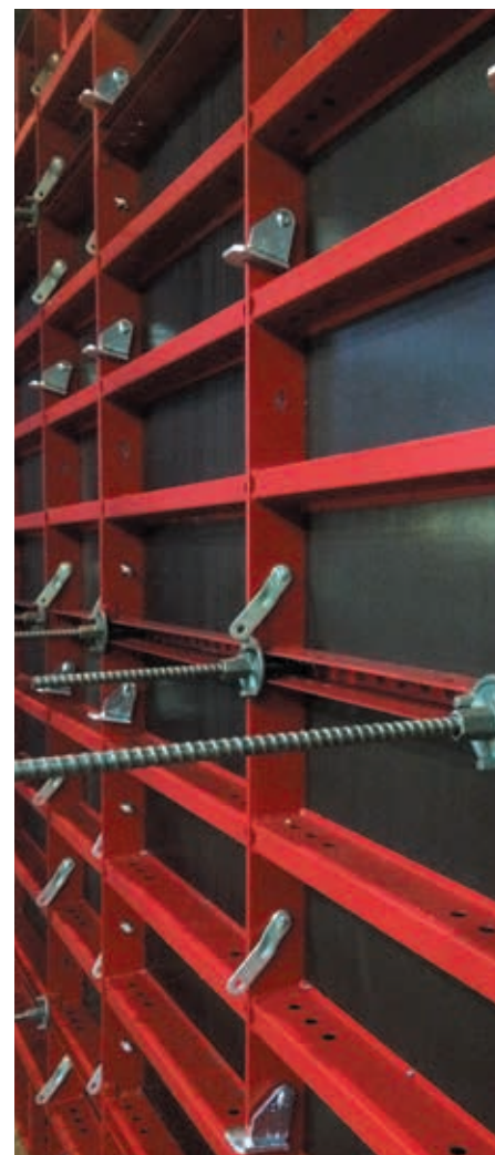
На фото: соединение щитов с помощью болта соединительного МСК и замка ударного U-clip.
