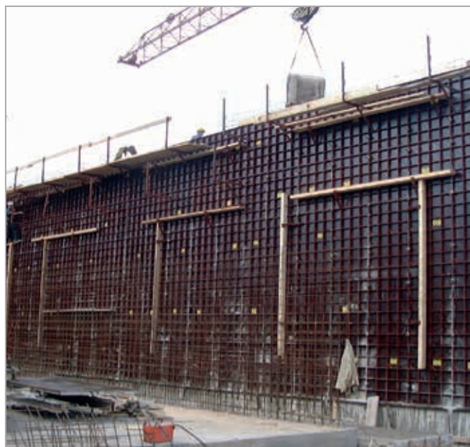
Опалубливание стены высотой 9 м.
