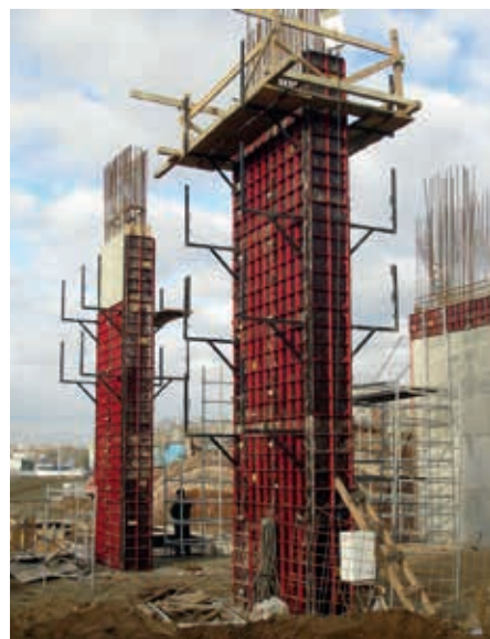
Формирование колонн высотой более 10 м
