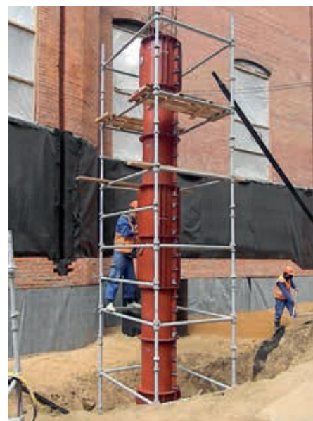
Круглая колонна из стандартных модулей
